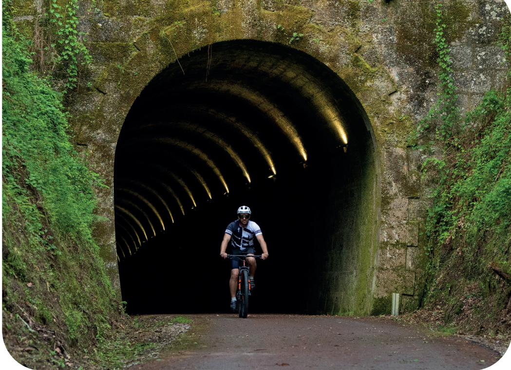
Viseu Túnel na Ecopista do Dão / Tunnel on the Dão Greenway
